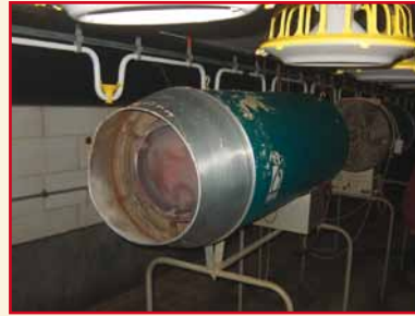
Figuur 25: Zowel een gasstraler (links) als een warme luchtblazer zijn brandgevaarlijk
