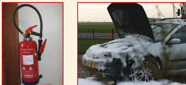
Figuur 56: Een schuimbrandblusser aan de muur (links) en in werking (rechts)
