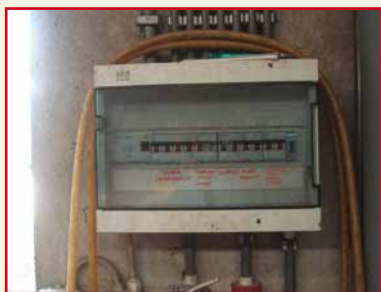
Figuur 21: Het benoemen van zekeringen (links) met een differentieelschakelaar (rechts)
