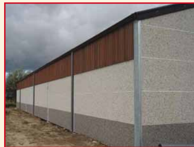
Figuur 12: Een opslagloods met stenen muren (links) of betonnen panelen (rechts)
