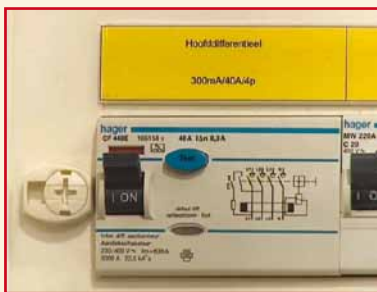
Figuur 21: Het benoemen van zekeringen (links) met een differentieelschakelaar (rechts)
